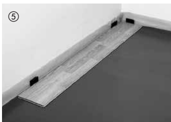
⑤ Lægningen startes i højre hjørne af rummet. Elementerne lægges med fersiden mod væggen og fikseres med afstandskiler (ekspansionsafstand til væg 10--15 mm).
