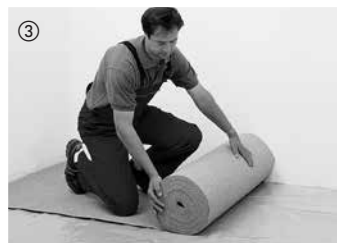
③ Til trinlydisolering og til udligning af mindre ujævnheder udrulles et 2 mm tykt lyd-dæmpningsunderlag af kork uden buler. Se også andre lyd-dæmpningsunderlag i vort tilbehørstilbud. Asfaltpap er ikke egnet til trinlydisolering. Ved HARO laminatgulv med Silent Pro ® må der ikke anvendes yderligere isolering.
